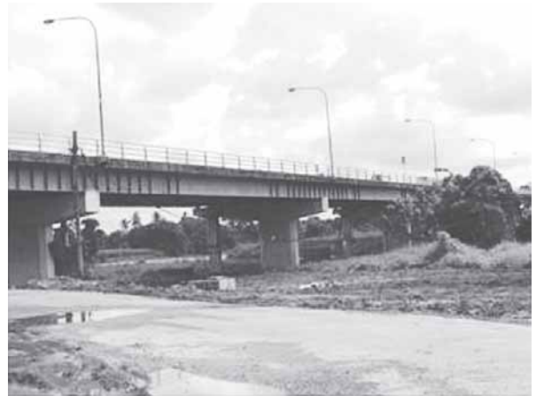
Datuk Chong Kiun Kong Bridge
